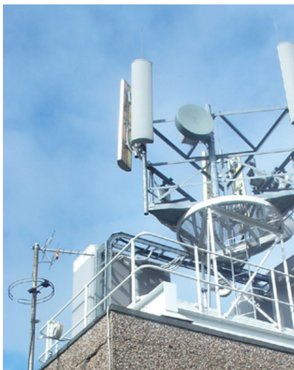
Illustration 10.1 — Antennes sectorielles de téléphonie mobile et antenne parabolique pour micro-ondes implantées sur le toit de la cage d'ascenseur
