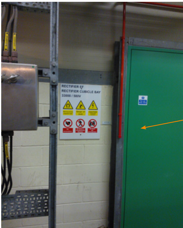
Illustration 3.3 — Restriction de l'accès à un compartiment de redresseur
