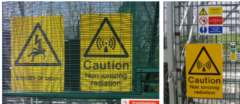
Illustration 12.4 — Avis d'avertissement affichés sur le portail de l'enceinte du radar (à gauche) et sur la grille de l'escalier d'accès au pylône d'antenne (à droite)
